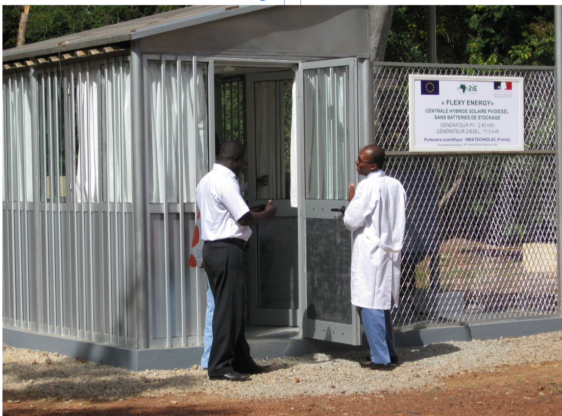
Prototype centrale « Flexy Energy » à Kamboinsé (puissance solaire : 2.8kWc ; générateur diesel 11.5 kVA)
